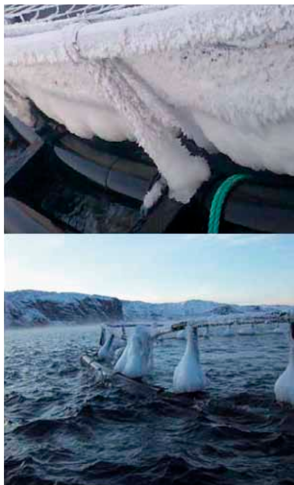
Figur 9 Eksempel på is på fuglenett, hoppenett og rekkestøtte (Foto Sponfish AS).
